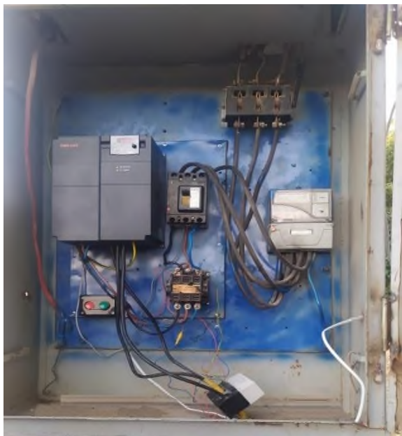
5-rasm. O'rnatilgan chastota o'zgartirgichning umumiy ko'rinishi
