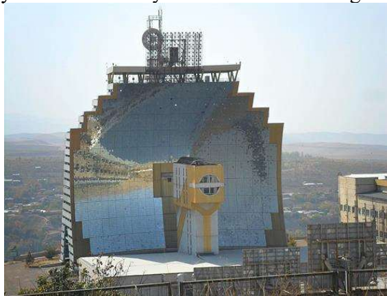
(1a-rasm) Bir mvt quvvatga ega bo'lgan Quyosh pechi.
