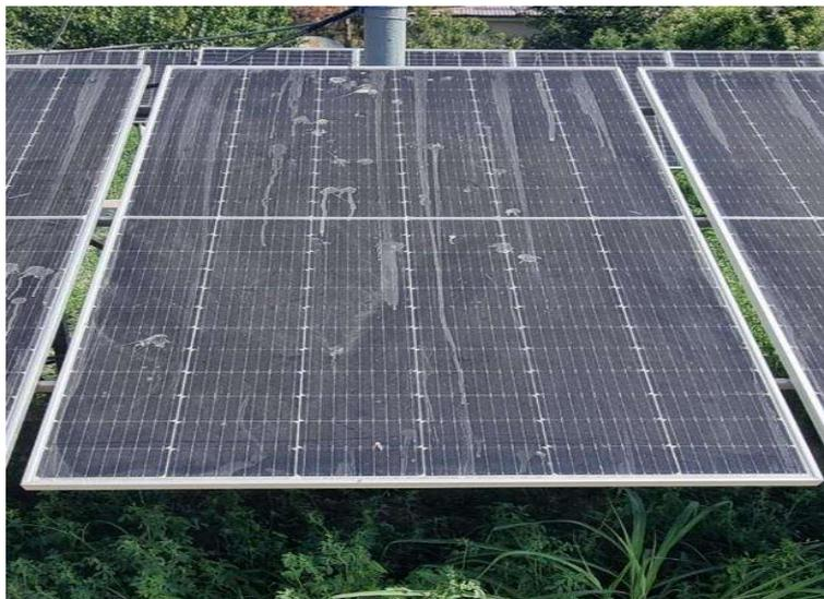
**Рис.2. Солнечная фотоэлектрическая станция мощностью (СФЭС) 5 кВт, покрытая пылью и песком.**
