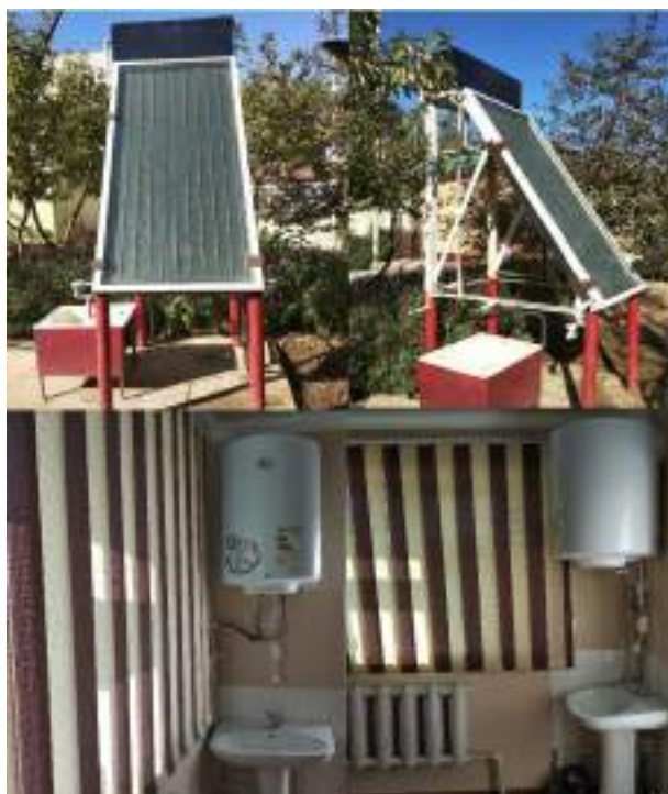
Рис.2. Система комбинированного горячего водоснабжения сельского дома.
